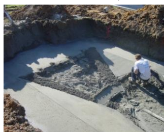
Mise en œuvre des pentes
