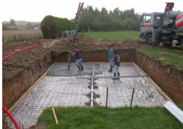
Mise en œuvre des pentes
