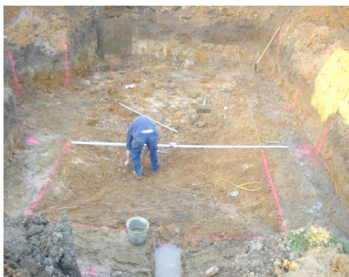
Vérification de la longueur piscine
