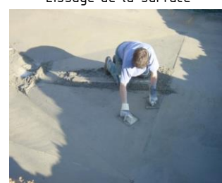
Lissage de la surface
