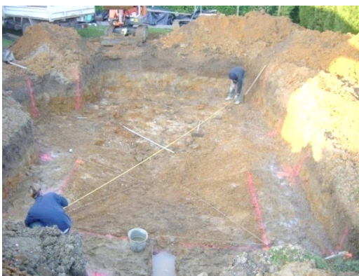
Vérification de la hauteur du fond
