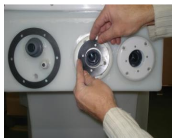
3 Collez 1x joint de bride sur la buse d'aspiration et la buse de refoulement
