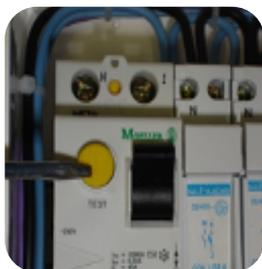
L'installation électrique de votre piscine doit être protégée par un disjoncteur différentiel 30 milliampères en amont.
