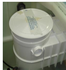
4 Colmatez le couvercle du skimmer avec du scotch pour éviter une prise d'air pendant le vide d'air
