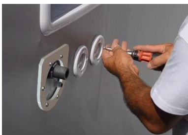
Bridage des vannes de chauffage (en option)
