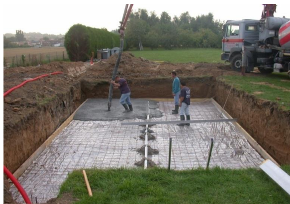
Mise en œuvre des pentes
