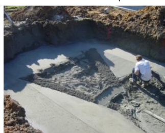
Mise en œuvre des pentes
