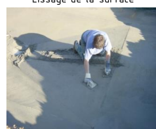
Lissage de la surface
