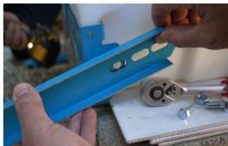
Côté coque, positionnez les supports sur les renforts de la coque. Pré percez un avant trou de Ø4 sur 1 à 1,5cm.
