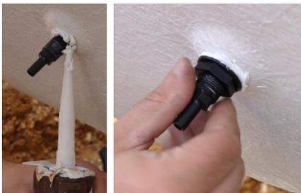
**3** A l'aide d'une pince, serrez l'écrou. Ne pas serrez trop fort l'écrou pour ne pas faire sauter le filetage
