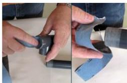
Nettoyer / dégraisser les surfaces à assembler
