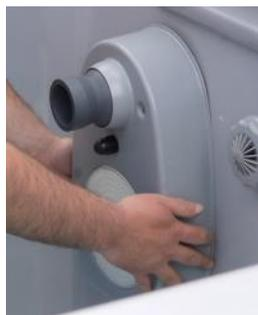
Montez les caches vis de bride. La rotule de refoulement et la grille d'aspiration chauffage
