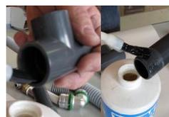
Emboîter les éléments avec une force régulière (avec ou sans mouvement de rotation en fonction de la colle)
