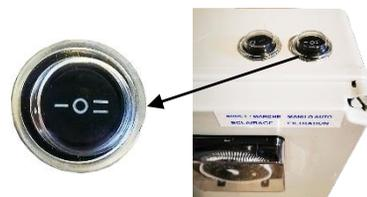
Un bouton pneumatique situé à l'intérieur du skimmer permet le démarrage de la filtration en « marche forcée ». Ce bouton vous permettra d'enclencher la nage à contre-courant depuis l'intérieur de la piscine sans ouvrir le bloc de filtration.
