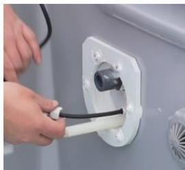
Laissez une longueur de câble à l'arrière du projecteur et enroulez le pour pouvoir sortir la façade du bassin sans réduire le niveau d'eau
