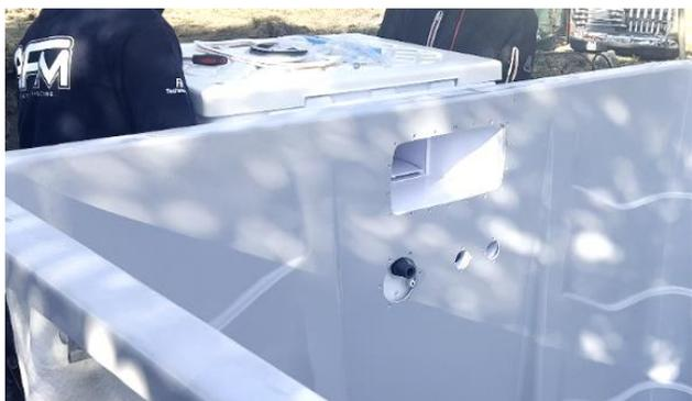
**2** Réalisez un calage sous le bloc pour maintenir en hauteur l'alignement de la face avant contre la coque.
